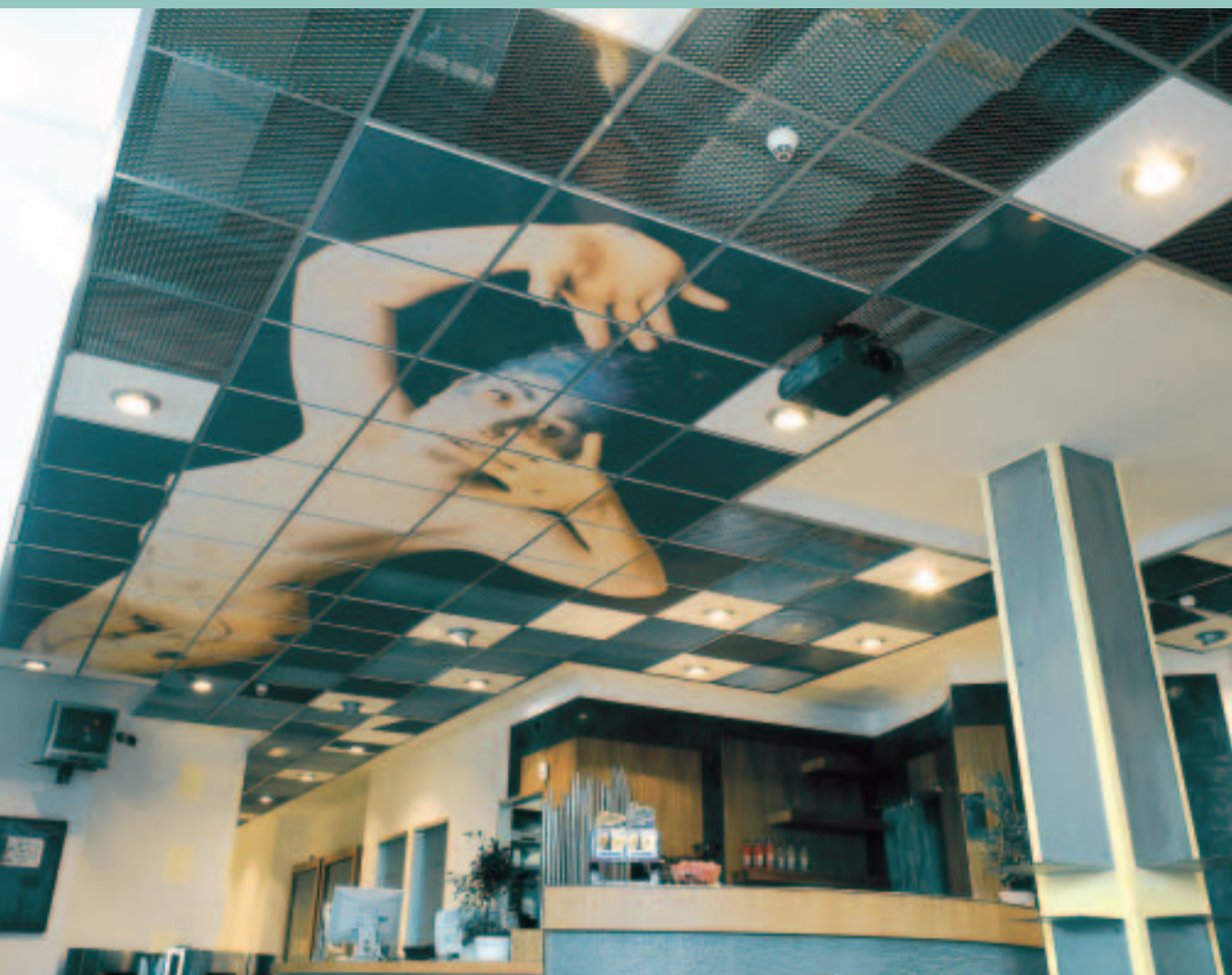
Palestra Fitness Progetto: Arch. Silvano Pagani - Bergamo Maglia: R16 x 8 x 2 x 1 mm Materiale: Ferro verniciato Foto: Luca Cattaneo - Bergamo
