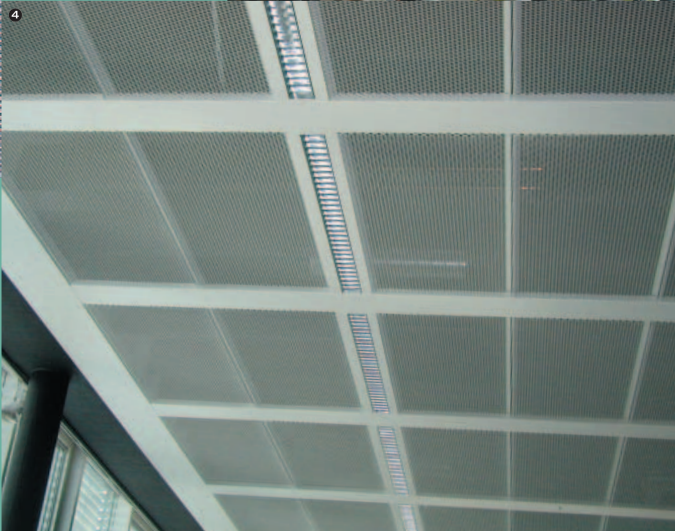
3/4/5 - UBS Dino-Center Projekt: Arch. Atelier WW - Zürich Masche: R28 x 10 x 2 x 1,5 mm Werkstoff: Stahlblech pulverbeschichtet
