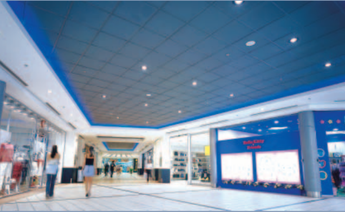
Centro Commerciale Maglia: Q8 x 6 x 1,2 x 1 mm Materiale: Ferro verniciato Foto: Proff Studio fotografico - Genova
