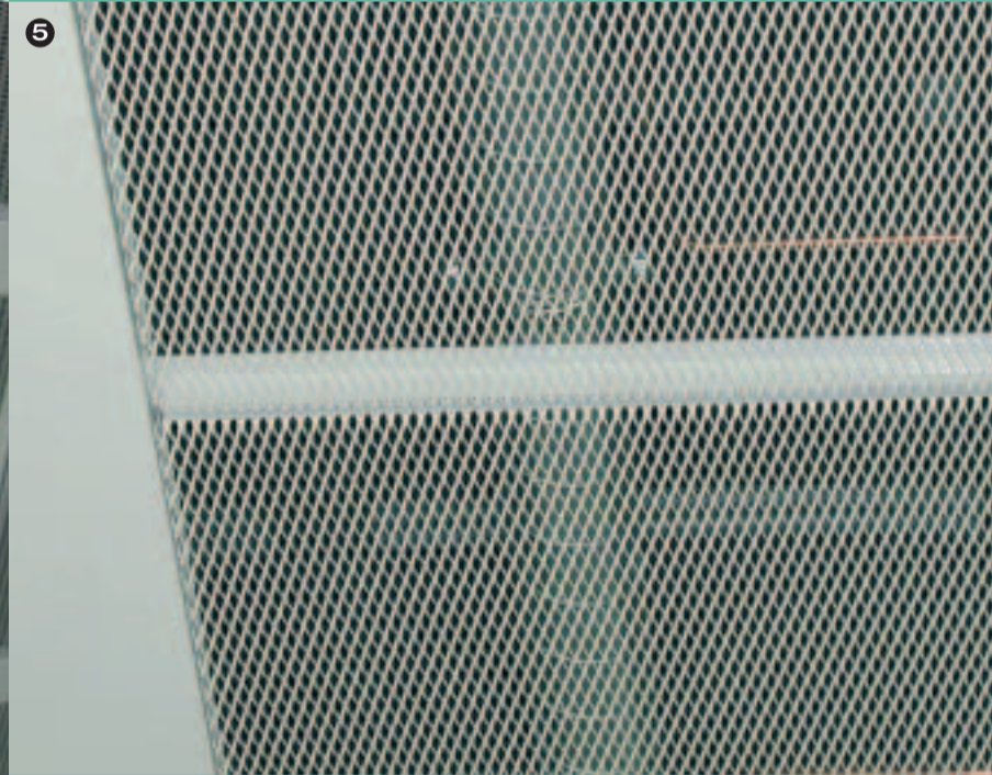
3/4/5 - UBS Dino-Center Projekt: Arch. Atelier WW - Zürich Masche: R28 x 10 x 2 x 1,5 mm Werkstoff: Stahlblech pulverbeschichtet
