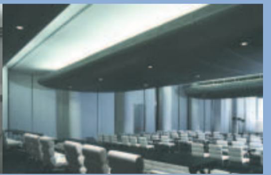
Sala Congressi Progetto: Studio King & Roselli - Roma Maglia: R45 x 8 x 3,5 x 1,5 mm Materiale: Ferro verniciato Realizzazione: Ingitec - Villa d'Almè - Bergamo
