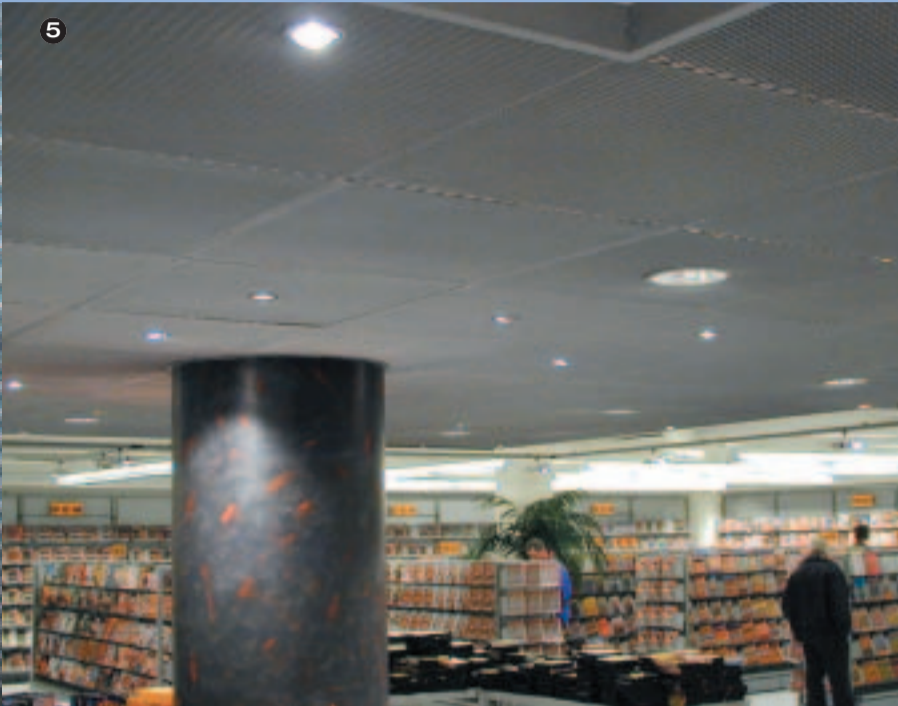
5/6 - Coop Masche: R43 x 13 x 2,5 x 1,5 mm Werkstoff: Stahlblech pulverbeschichtet
