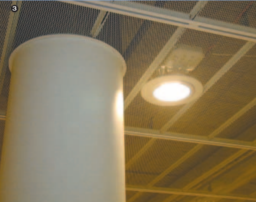
3/4 - Einkaufszentrum Masche: R28 x 10 x 2 x 1,5 mm Werkstoff: Stahlblech pulverbeschichtet
